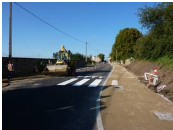
Le chantier en cours
