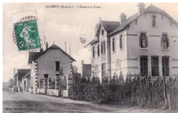
L'école de filles (actuelle mairie) et le bureau de poste peu après leur construction.
