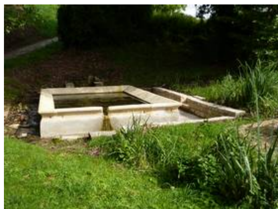
Le lavoir en cours de restauration
