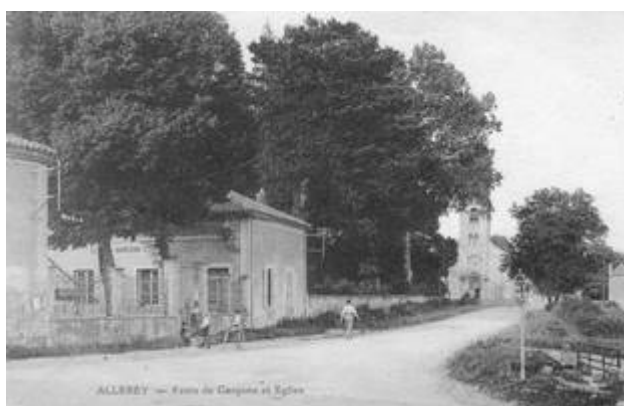
L'école de garçons et la mairie qui lui fait face dont le bâtiment fut détruit à la fin des années 1960. A droite : le poids public.
