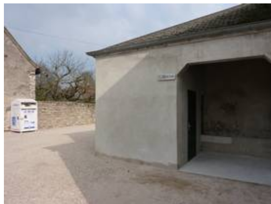
Vue extérieure du WC public
